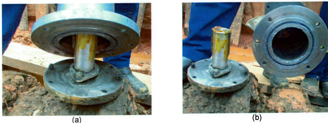
Fig. 09 (a) e (b): Redutores com diâmetros de carretel maiores que o diâmetro do carretel da válvula
