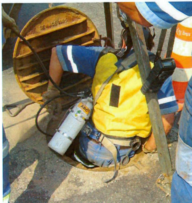
Fig. 08: Operação de acesso à caixa em espaço confinado
